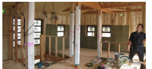
健康住宅の建築現場。建材・内装材は、安全データ等で確認して使用。電磁波対策は、特殊繊維を張ってアースで抑制。断熱材は、天然羊毛材で結露防止も行う。
